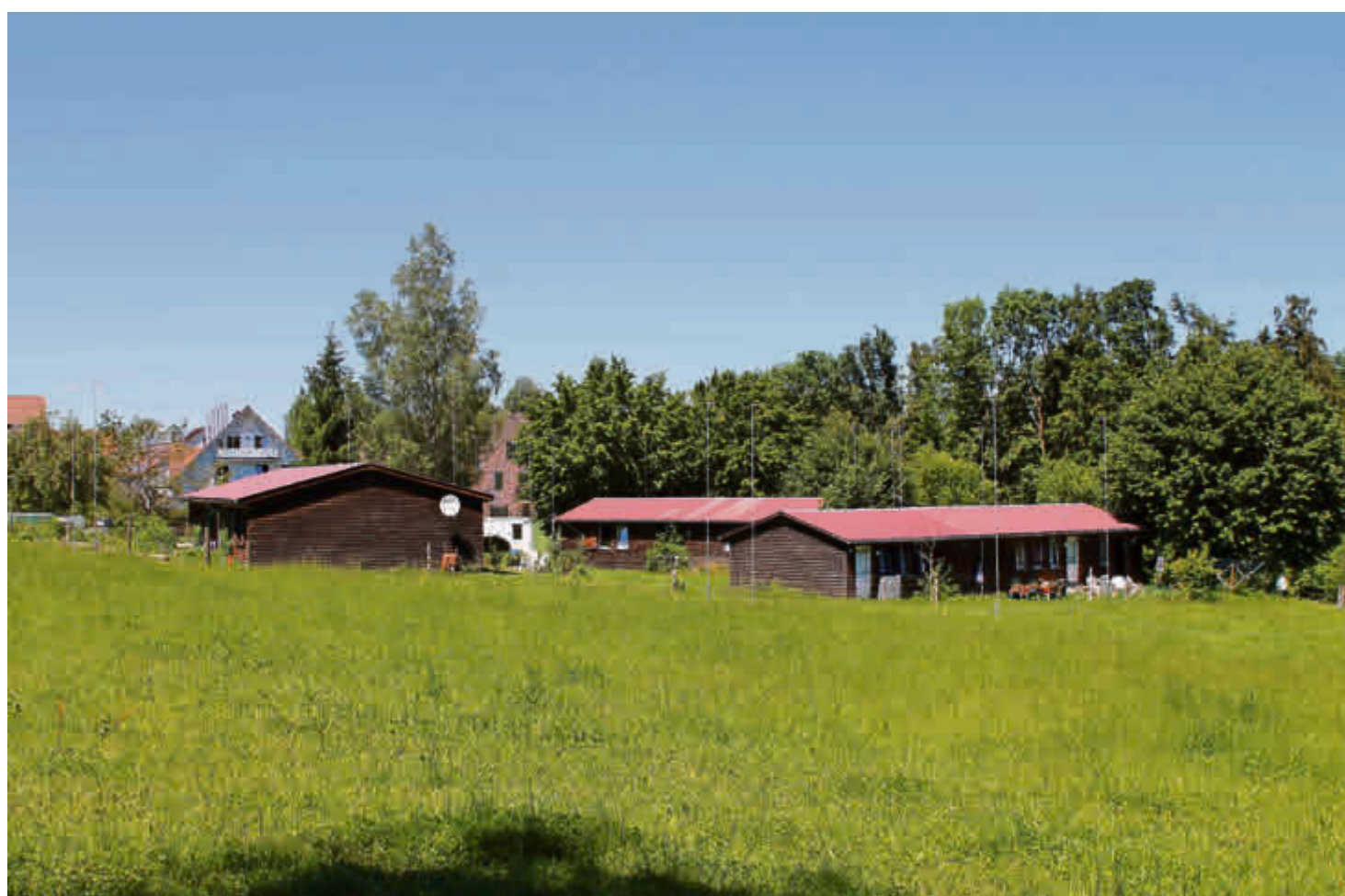
Alte Asylunterkünfte haben ausgedient: Zwei der drei einstöckigen Baracken werden durch zweistöckige Modulbauten ersetzt.
